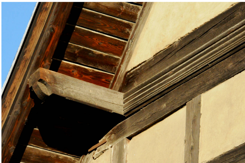
Links Balkenkopf einer Pfette. Rechts profilierte Verkleidung der Deckenbalken (Foto: R. Wahl)
